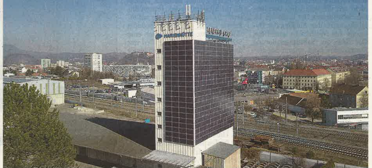
Der „Power Tower“: ein mit Fotovoltaikzellen verkleideter Turm des Grazer Stahlwerks Marienhütte.
